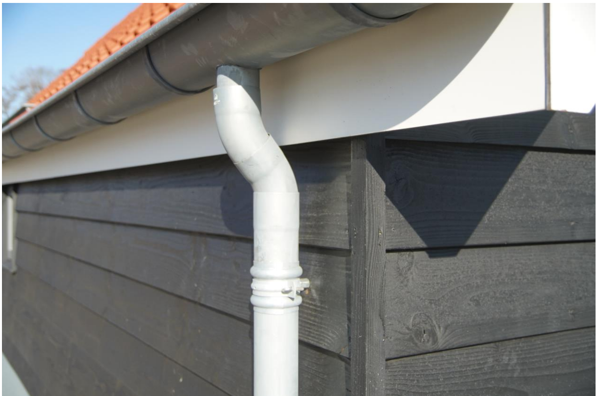
Trapgat met overloop
